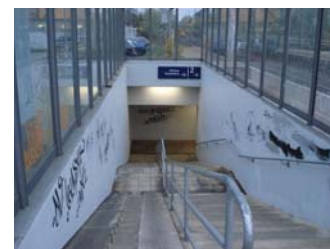
Der Tunnel zum anderen Bahnsteig, erst vor kurzem sind die Schmierereien kostspielig übertüncht worden. Was sind das für widerliche Gestalten, die sich feige hinter ihren sinnlosen Kritzeleien verstecken?
