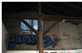
Der erste Eindruck von innen. Es kommt noch viel schlimmer.
