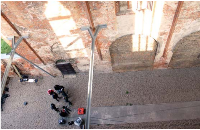
Von der Krone der südlichen Mauer des Kirschenschiffs gesehen...
